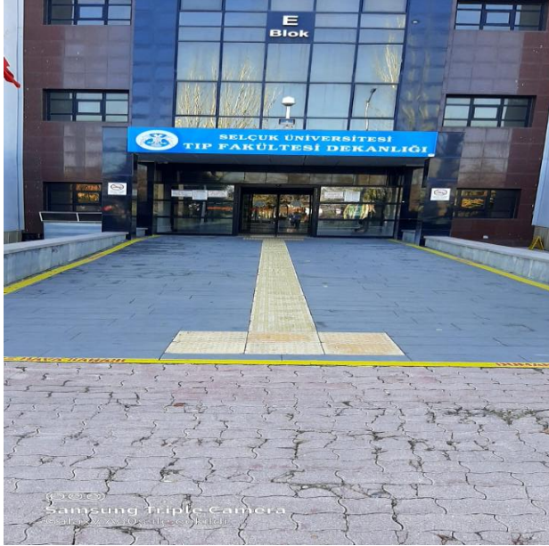
Şekil TS.7.1.7/3 Girişlerde Engelli yürüme bandı
